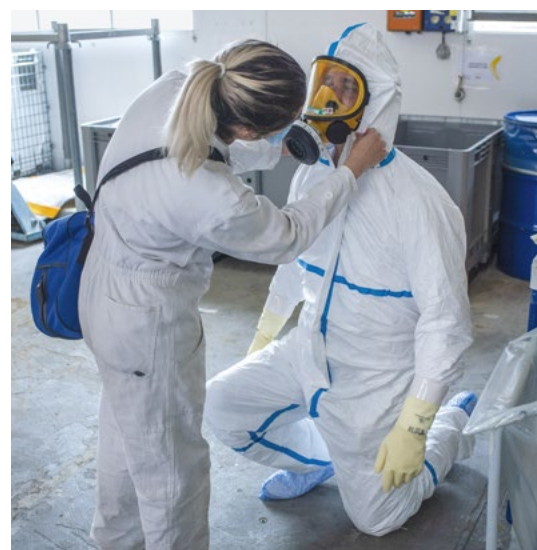
Figure 20. Port d'une tenue non ventilée, gants et masque complet avant d'entrer dans une zone de contamination radioactive en cours de démantèlement
